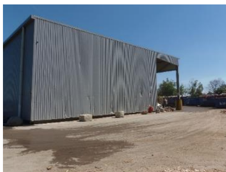
Bâtiment exploité dans lequel niche le Moineau domestique. (Biotope, 2020)
